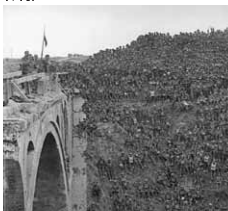
Pont de Riqueval en 1918
